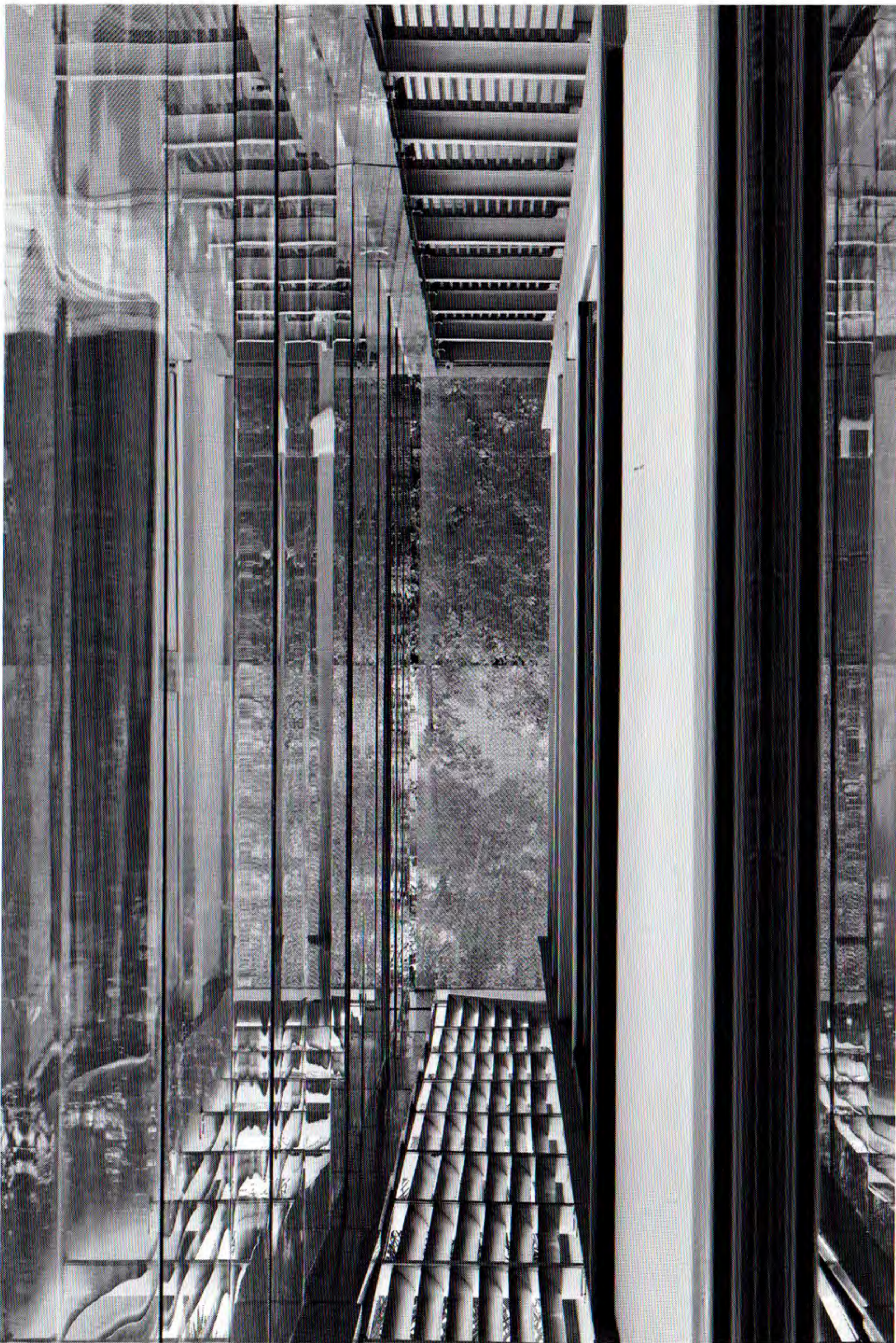
Double skin wall on first floor 2階, ダブル・スキンの壁
